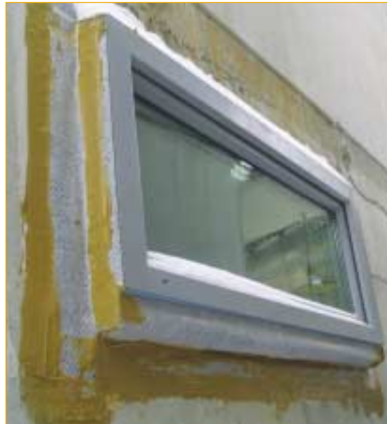
SLIKA 5 Primer gradnje pasivne večstanovanjske stavbe, debelina toplotne zaščite (socialni / neprofitni sektor) na Dunaju (foto: MŠZ).
