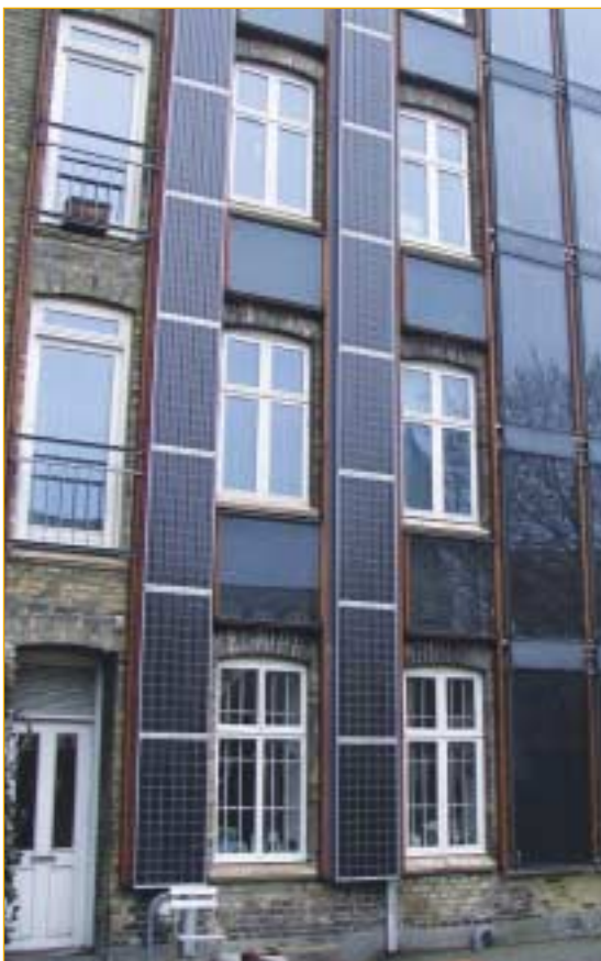
SLIKA 6 Prenova starejše stavbe z elementi za izkoriščanje obnovljivih virov energije v Aarhusu (foto: MŠZ)
