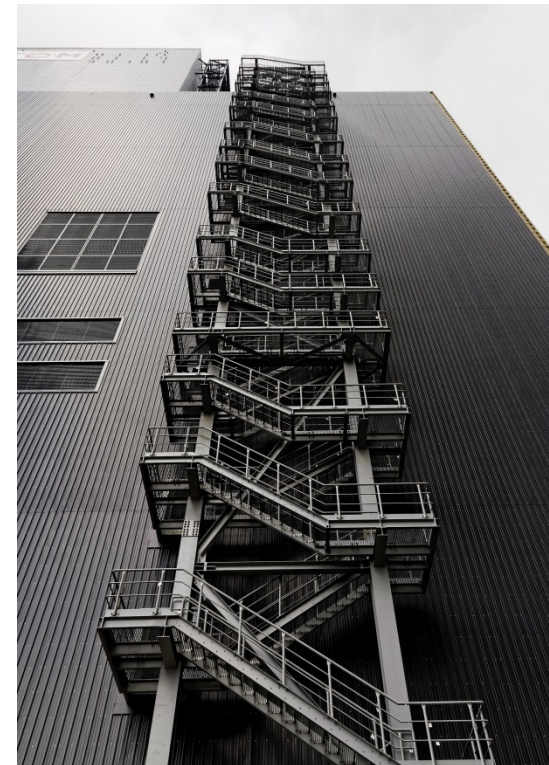
Avtor fotografije: Edvard Weiss Inženirski objekt: TEŠ 6 s požarnimi stopnicami
