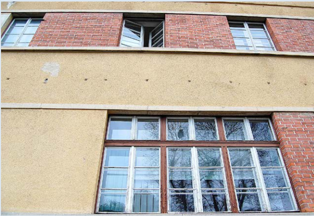
Slika 14: Pri obnovi fasad ni dovoljeno prekriti odprtin, namenjenih zračenju stropnikov.
