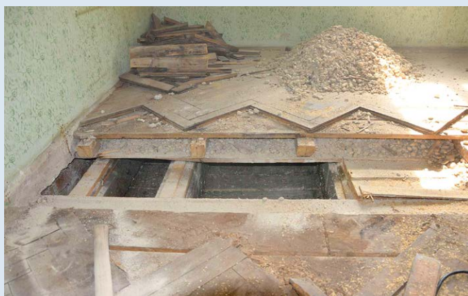
Slika 13: V primeru pomanjkljive dokumentacije je treba pred načrtovanim posegom stropno konstrukcijo odpreti in ugotoviti njeno dejansko sestavo in dimenzije.
