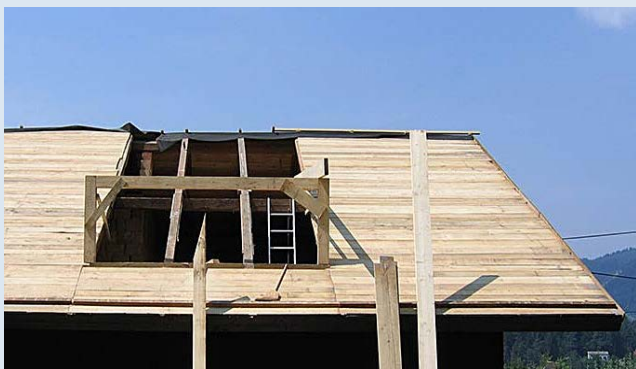
Slika 20: Izdelava frčade zahteva delno odstranitev špirovcev in izdelavo t. i. menjalnika.
