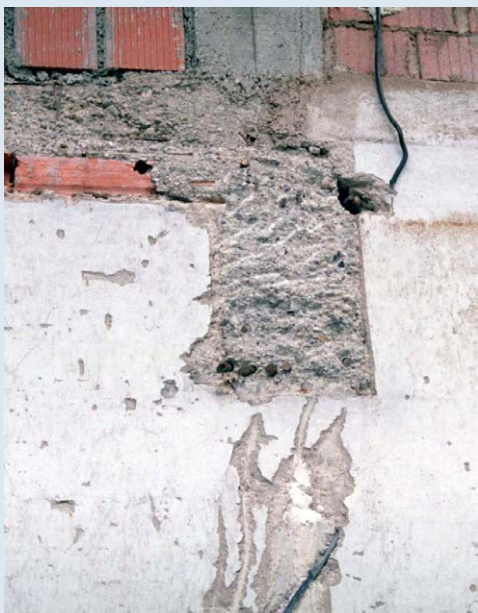
Slika 18: Odstranjeni del AB nosilca.
