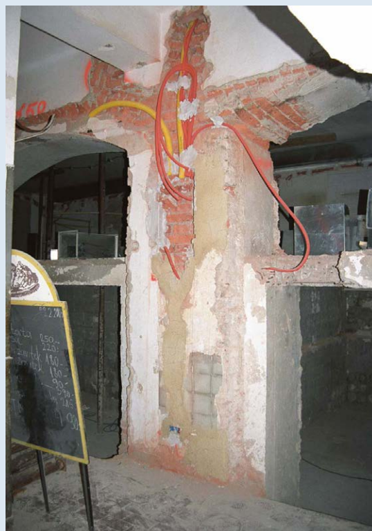
Slika 2: Nevarne oslabitve na zelo obremenjenem mestu, kjer se lok stika s stebrom.
