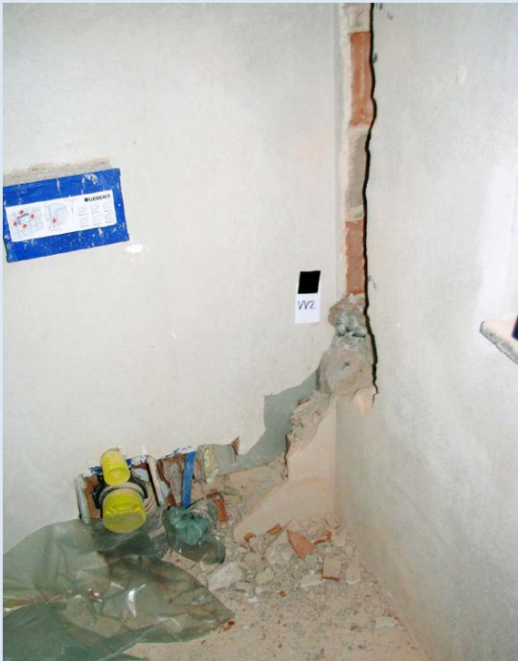
Slika 3: Prekinitev navpične AB zidne vezi z utorom.
