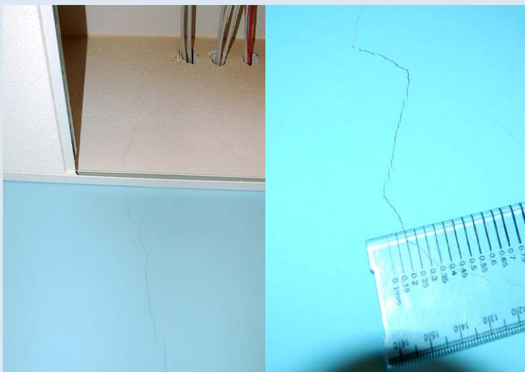
Slika 6: Razpoke v prekladi na mestu odstranjene nosilne stene.
