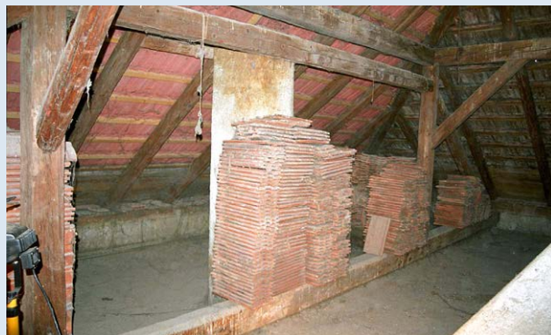
Slika 22: Spodnjih poveznikov v vešalih ni dovoljeno odstraniti oziroma prežagati in ne dodatno obremenjevati (kritina).
