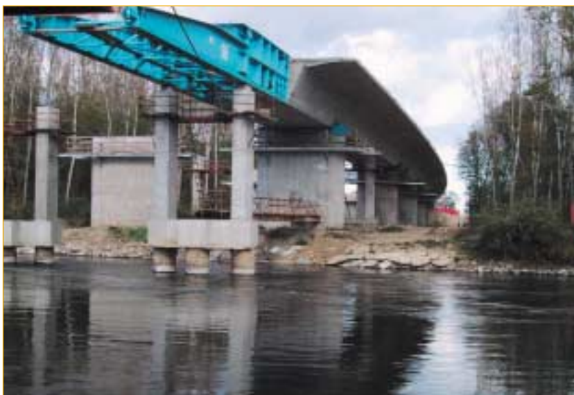
SLIKA 10 Prečkanje reke s prvo konstrukcijo - november 2001
