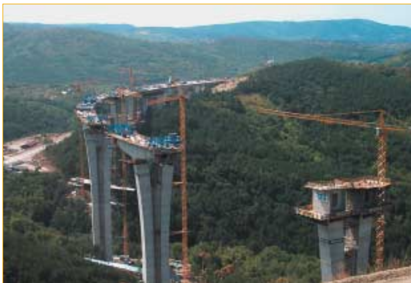
SLIKA 5 Pogled na viadukt v fazi gradnje s ceste Ljubljana – Koper
