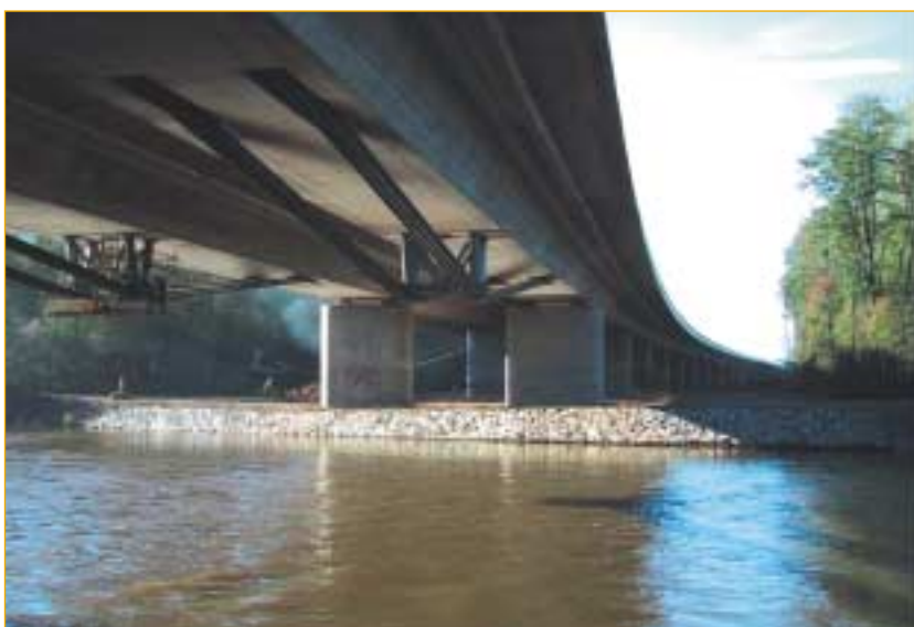
SLIKA 12 Glavni razpon s poševnimi kabli in jeklenim deviatorjem (oktober 2003)
