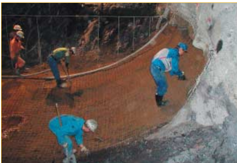
SLIKA 5 Vgradnja talnega oboka iz brizganega cementnega betona MB25 debeline 35 cm
