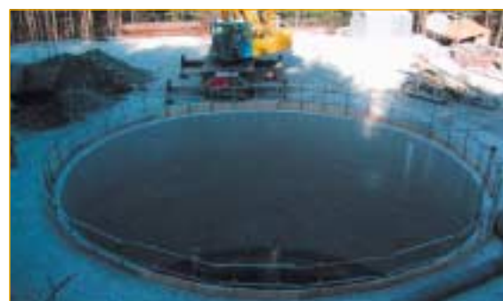
SLIKA 12 Izvedba betonskega prstana ter izkop vodnjaka podpore 5
