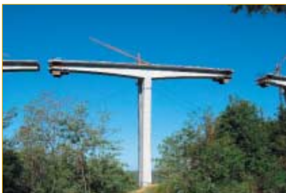
SLIKA 14 Pogled na visoke stebre - konzolne mize v fazi gradnje voziške konstrukcije
