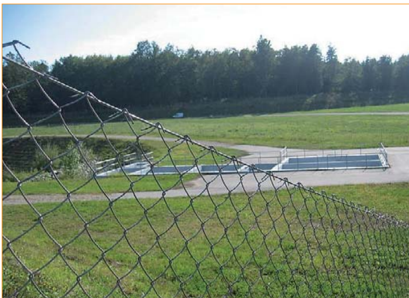
SLIKA 2 Ponikovalnica z betonskim objektom za čiščenje padavinske vode z avtoceste v Mariboru (foto Petra Kralj)
