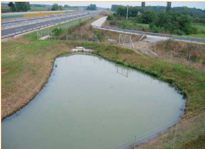
SLIKA 1 Zemeljski objekt za čiščenje padavinske vode z avtoceste (foto Petra Kralj)
