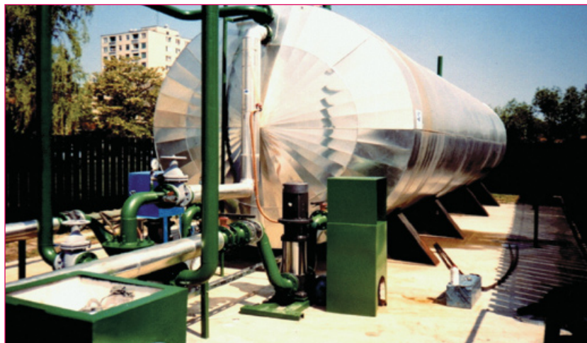
SLIKA 14: Površinski reinjekcijski sistem.
