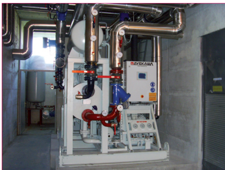
SLIKA 8: Visokotemperaturna toplotna črpalna.
