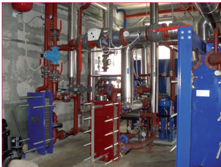
SLIKA 6: Toplotni izmenjevalnik 2,7 MW t .
