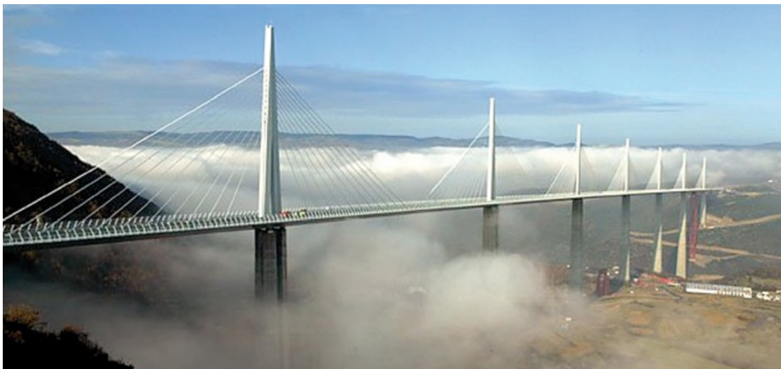
Slika 6: Viadukt Millau – izveden objekt
