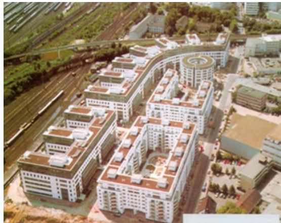
Slika 5: Primer, kjer so klimatsko – prezračevalne naprave nameščene na streho objekta.
