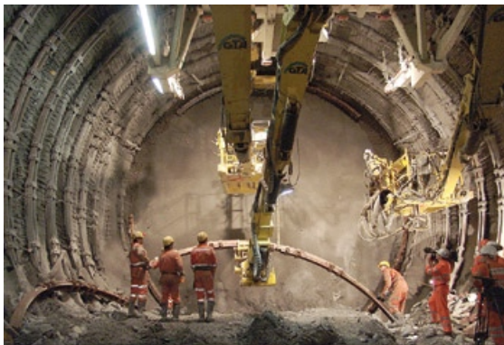
Slika 3a: Izkopno čelo in nameščanje jeklenega podpornega loka
