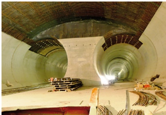
Slika 3b: Betoniranje notranje obloge
