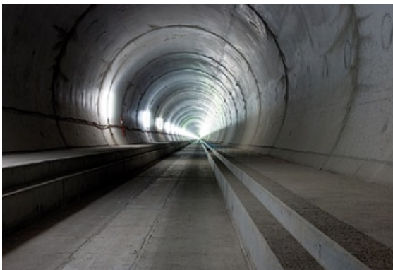
Slika 3c: Dokončana gradbena dela
