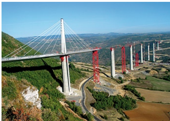
Slika 5: Narivanje voziščne konstrukcije
