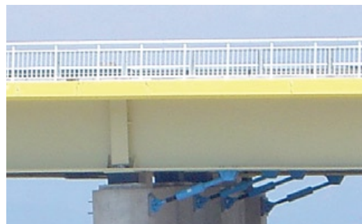
Slika 11: Številni hidravlični dušilci omogočajo horizontalno in vertikalno fleksibilnost konstrukcije
