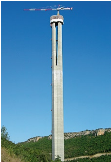
Slika 4: Betonski stebri, višine do 245 m
