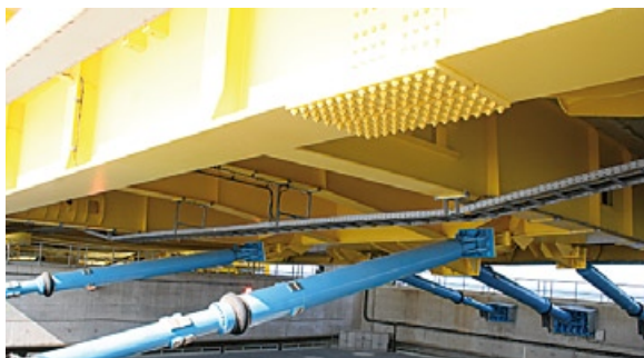
Slika 11: Številni hidravlični dušilci omogočajo horizontalno in vertikalno fleksibilnost konstrukcije
