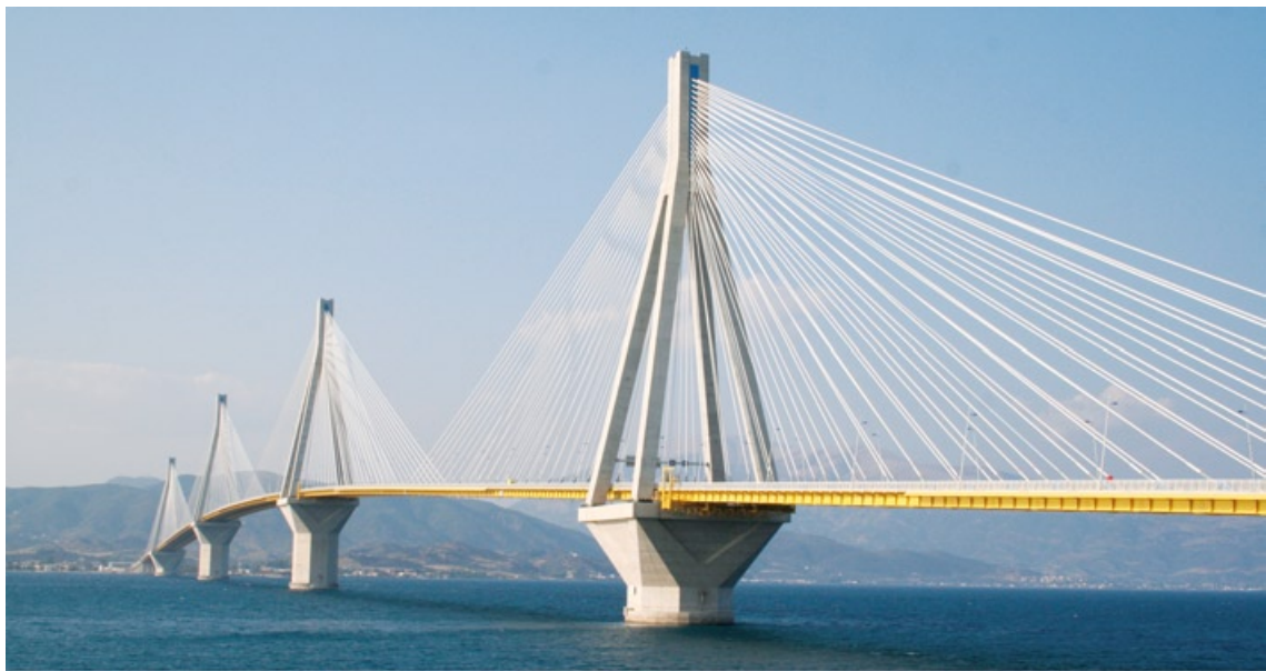
Slika 7: Most Rion-Antirion – glavni most, dolžine 2.252 m, z maksimalnim razponom 560 m
