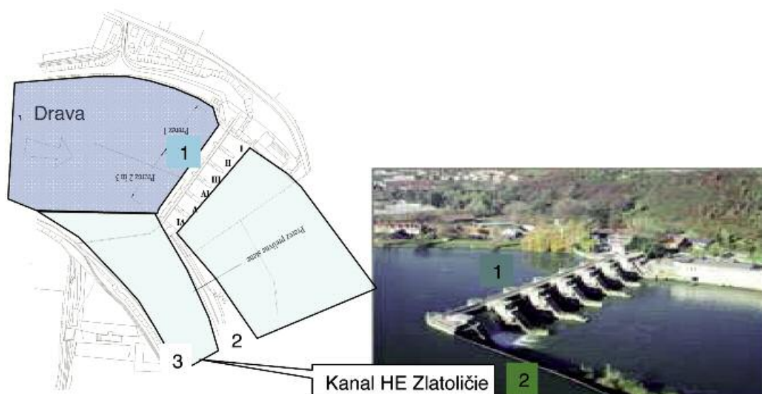
1 – jez; 2 – levoobrežna in 3 – desnoobrežna stena dovodnega kanala
