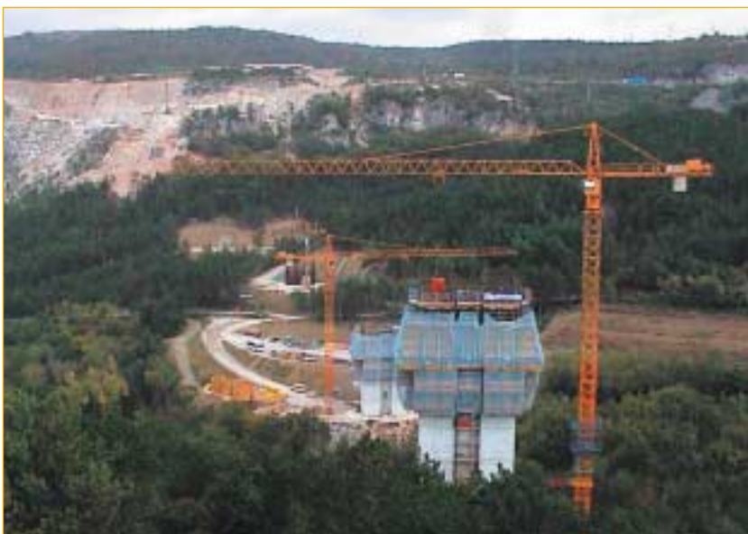
SLIKA 16 Pogled na opornik 1 ter vkop za zgornjo traso
