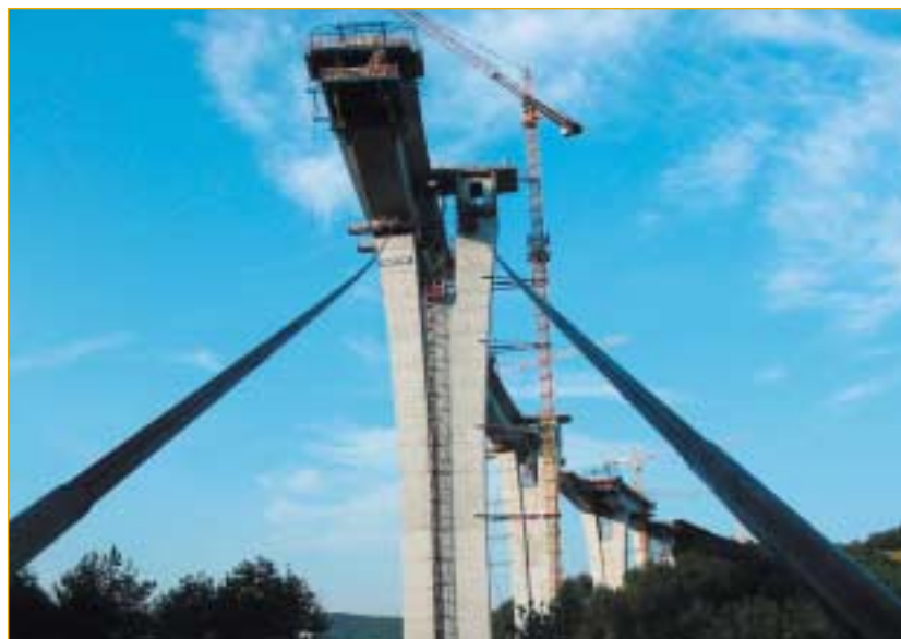
SLIKA 15 Pogled na stebre 5, 6, 7, ki so v fazi konzolne gradnje dodatno pridrževani s kabli
