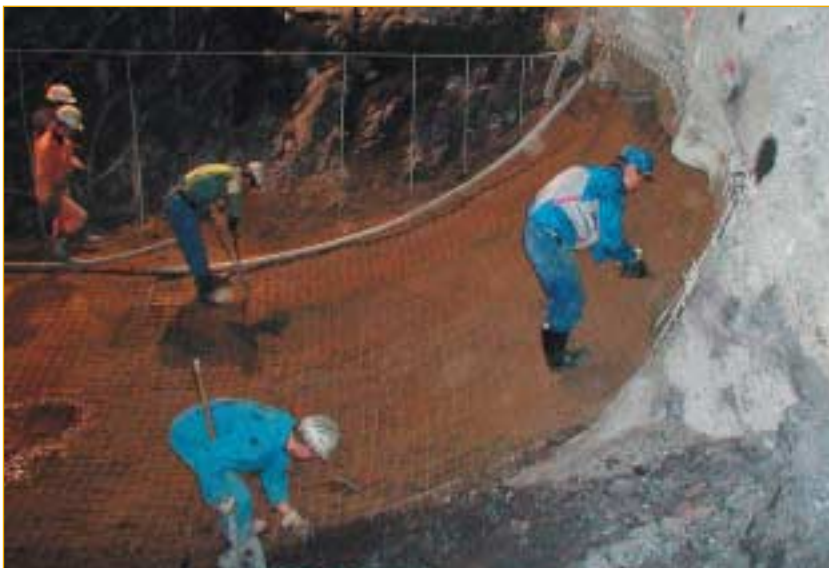
SLIKA 5 Vgradnja talnega oboka iz brizganega cementnega betona MB25 debeline 35 cm
