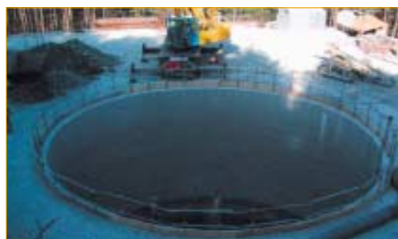
SLIKA 12 Izvedba betonskega prstana ter izkop vodnjaka podpore 5
