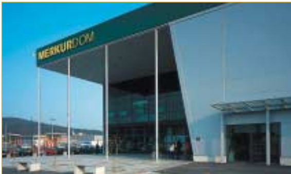
SLIKA 5 Vitke konstrukcije kot arhitekturni trend (TC Merkur, Rudnik)
