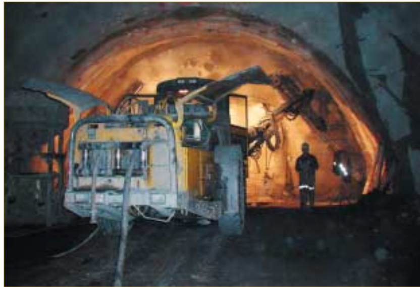
SLIKA 7 Vgradnja mikropilotov v desni bok predorske cevi
