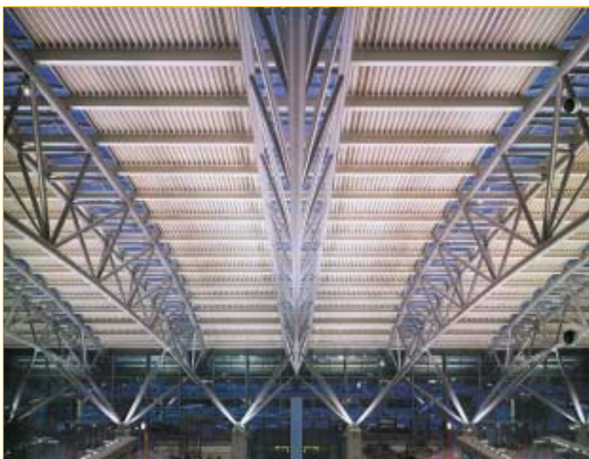
SLIKA 1 Ločna palična cevna konstrukcija- Letališče Hamburg
