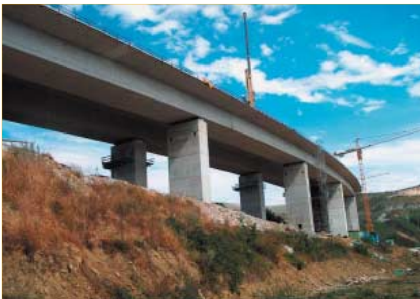
SLIKA 10 Pogled na izgotovljen pobočni del viadukta z ločenimi stebri, september 2003
