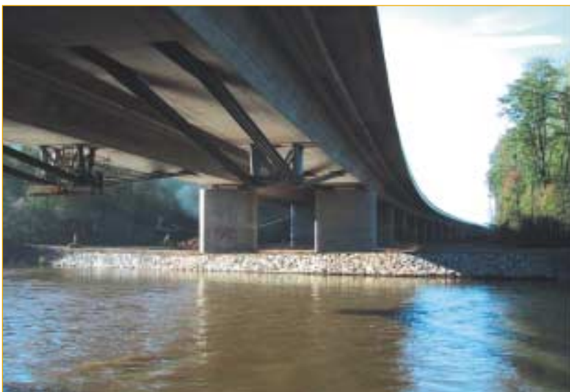
SLIKA 12 Glavni razpon s poševnimi kabli in jeklenim deviatorjem (oktober 2003)
