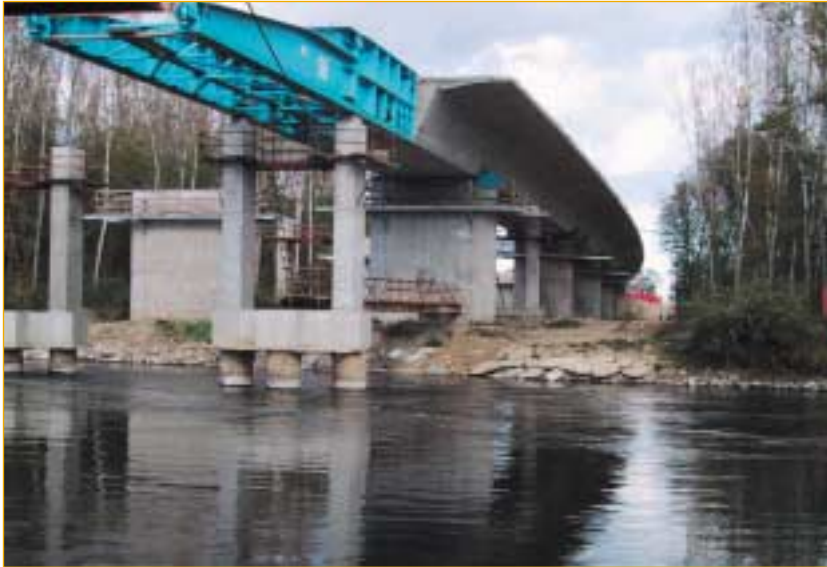
SLIKA 10 Prečkanje reke s prvo konstrukcijo - november 2001
