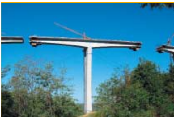
SLIKA 14 Pogled na visoke stebre - konzolne mize v fazi gradnje voziščne konstrukcije
