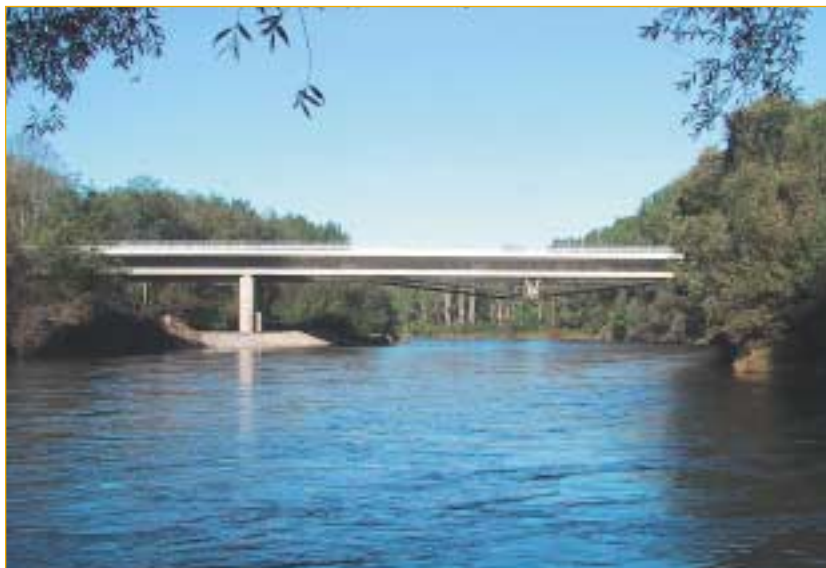
SLIKA 13 Pogled gorvodno na del glavnega razpona (oktober 2003)
