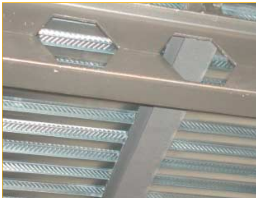
SLIKA 13 Sovprežni strop na HiBond pločevini
