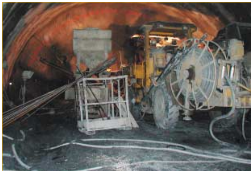
SLIKA 9 Priprava na vgradnjo jeklenega cevnega ščita
