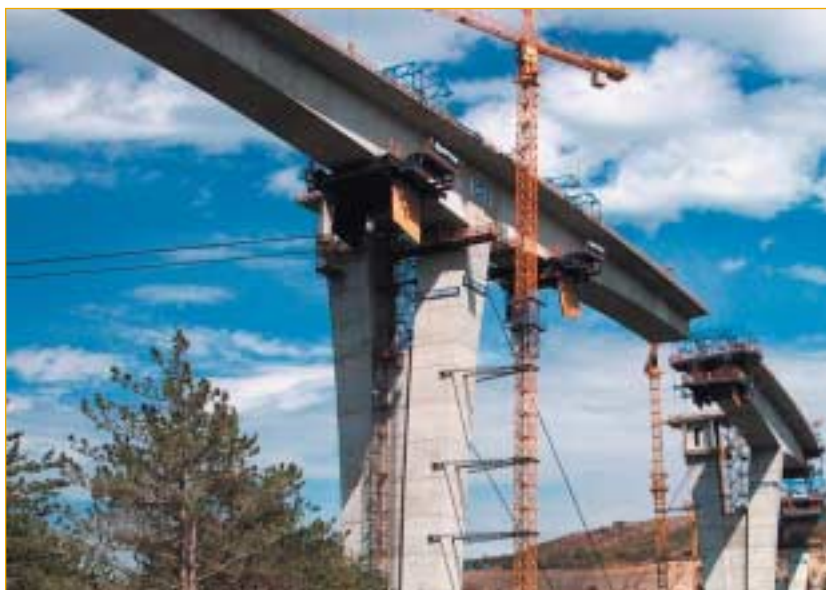
SLIKA 7 Pogled na viadukt v fazi gradnje, oktober 2003
