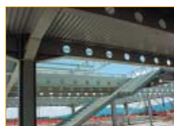
SLIKA 14 Sovprežni strop na HiBond pločevini-Merkur Ljubljana
