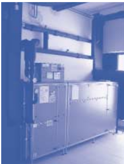
Slika 3: Energetsko varčna klimatizacijska naprava
