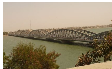
Faïdherbe Bridge. Saint-Louis du Sénégal (1897)
