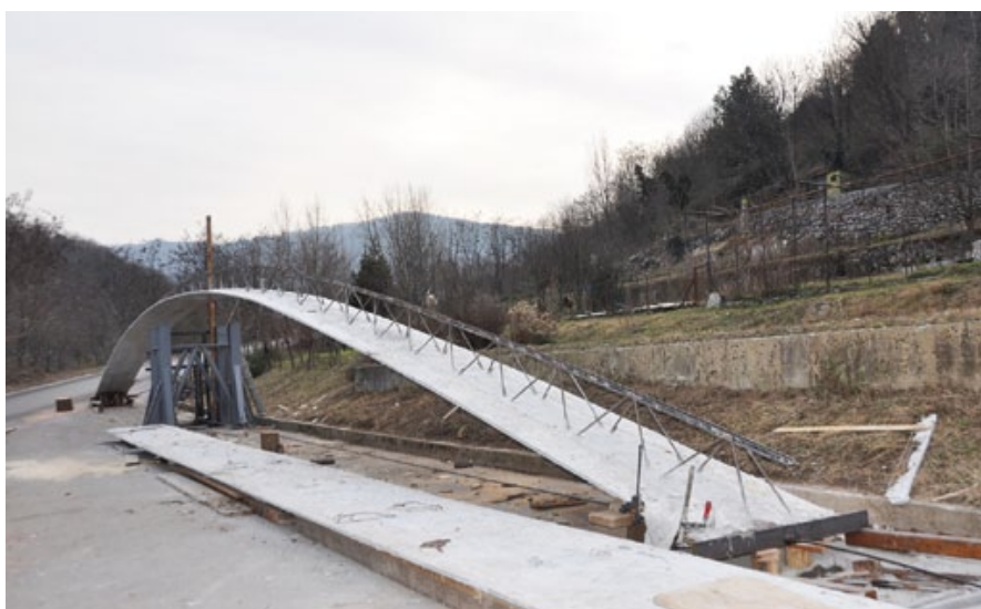
Moja doslej najdaljša krivljena plošča meri 36 m. Pred prevozom proti Trenti oz. v Sočo, jo bo potrebno prerezati.
