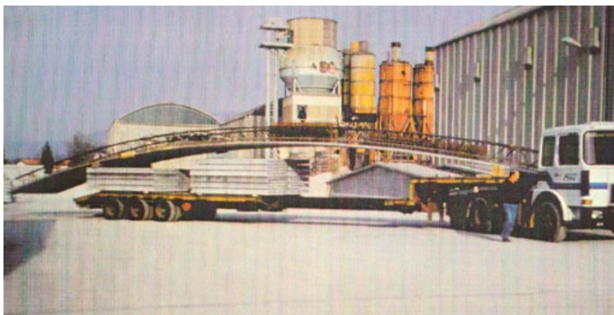
Nosilci za most čez Sočo v Doblarju pred tovarno, v kateri sem začel kriviti izredno tanke prednapete plošče, kar bi lahko pomenilo revolucijo v gradnji mostov po Sloveniji in drugod po svetu, pa ...
