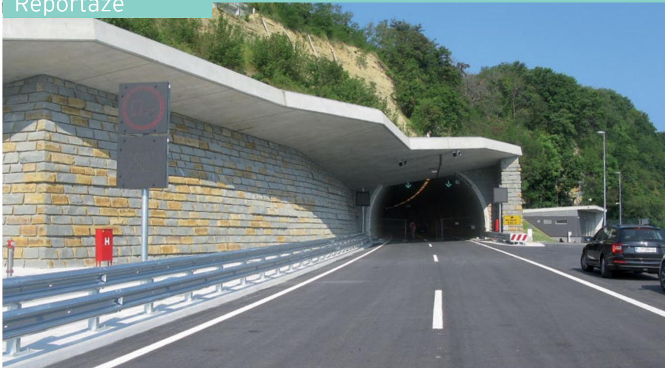
Predor Markovec kot objekt sodi v skupino rizičnih objektov, zato je v njem vsa oprema dvojna.
