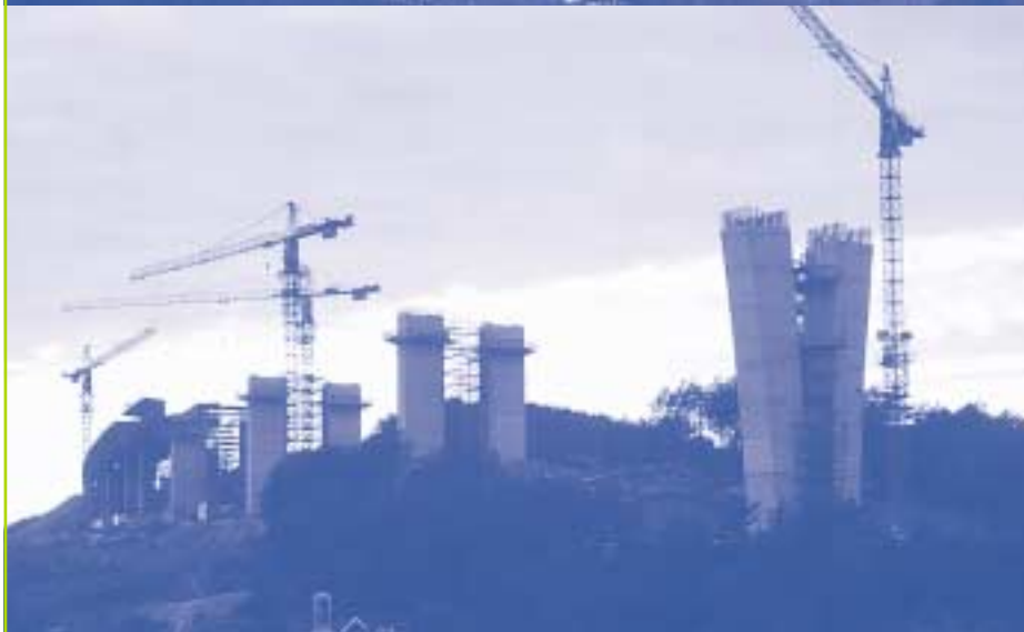
Viadukt Črni kal
