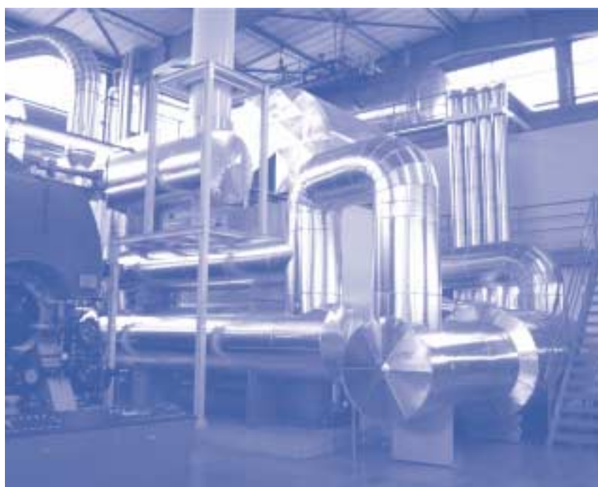
Slika 4: Namestitve SPTE v kotlovnici TOM
