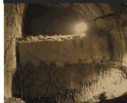
SLIKA 7 > Način izkopa in primarnega podpiranja v stopnici in talnem oboku priključne kaverne (Črepišek M. 2006).
