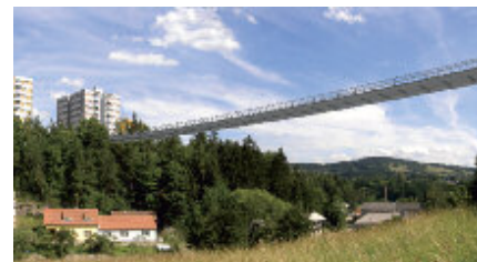
Most za pešce Cesky Krumlov z razponom 167,8 m povezuje historični in novi del mesta (avtor vabljeni predavatelj Jiri Strasky).
