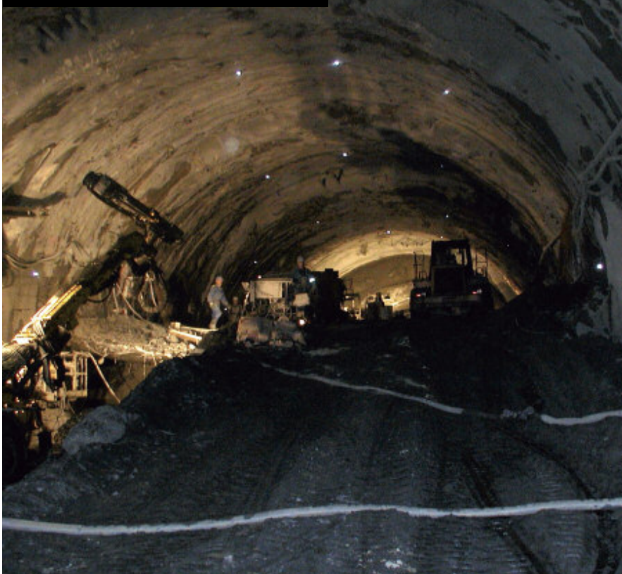
SLIKA 5 > Gradnja tripasovne predorske cevi.
