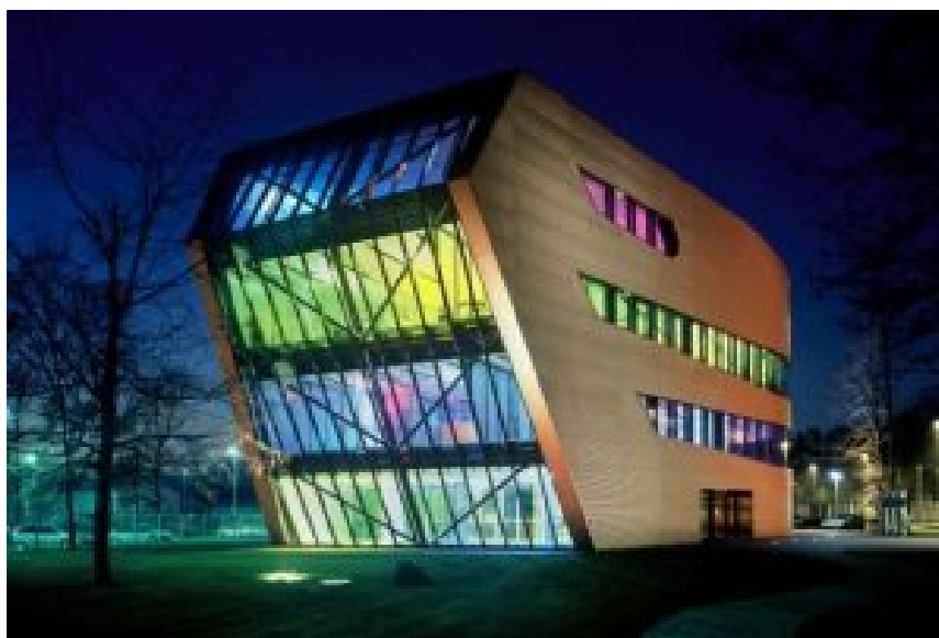
Na gradnjo prihodnosti moramo misliti že danes
