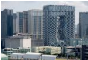
Hotel Morpheus v Macau na Kitajskem - prva zgradba na svetu, zgrajena s prostostoječim zunanjim jeklenim ogrodjem. (Foto: EPA)
