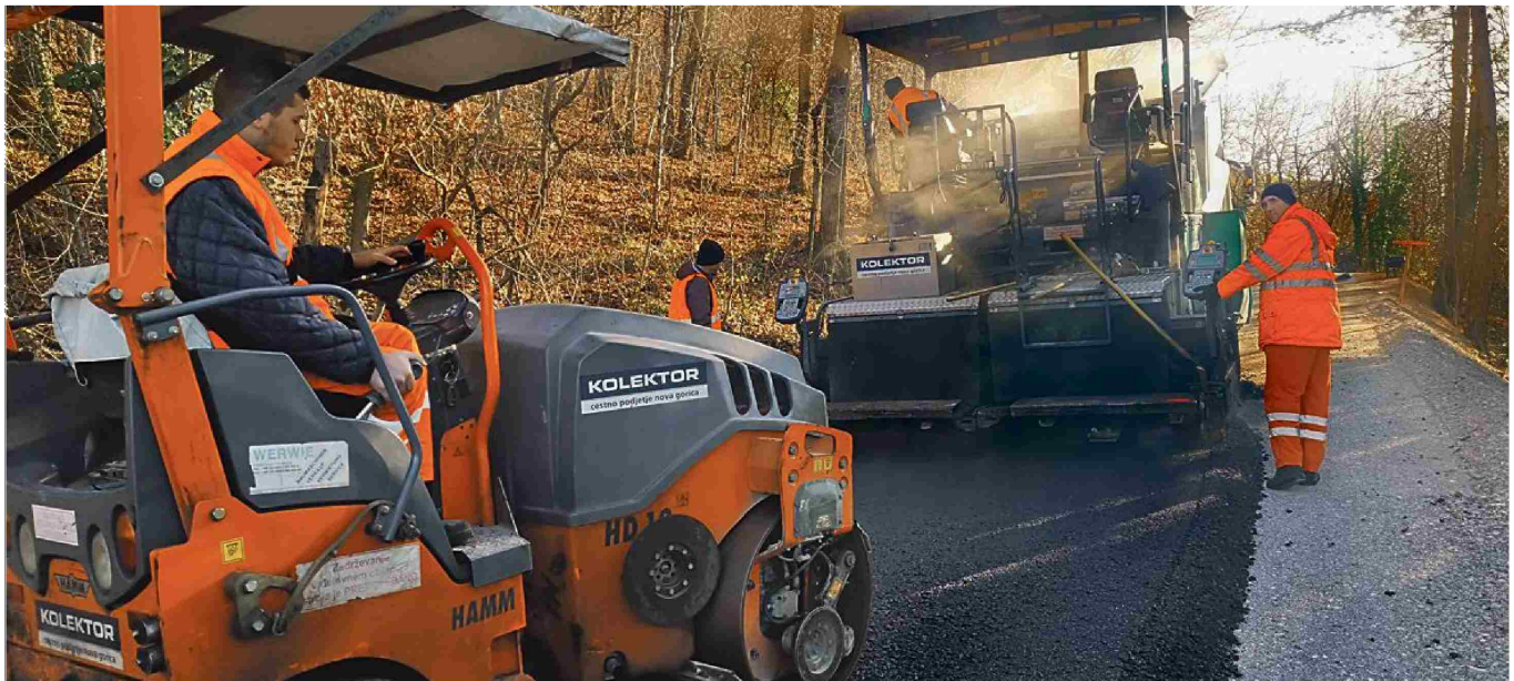
Asfaltirajo približno tri metre široko pot do gradbišča drugega tira. FOTO BORIS ŠULIGOJ
