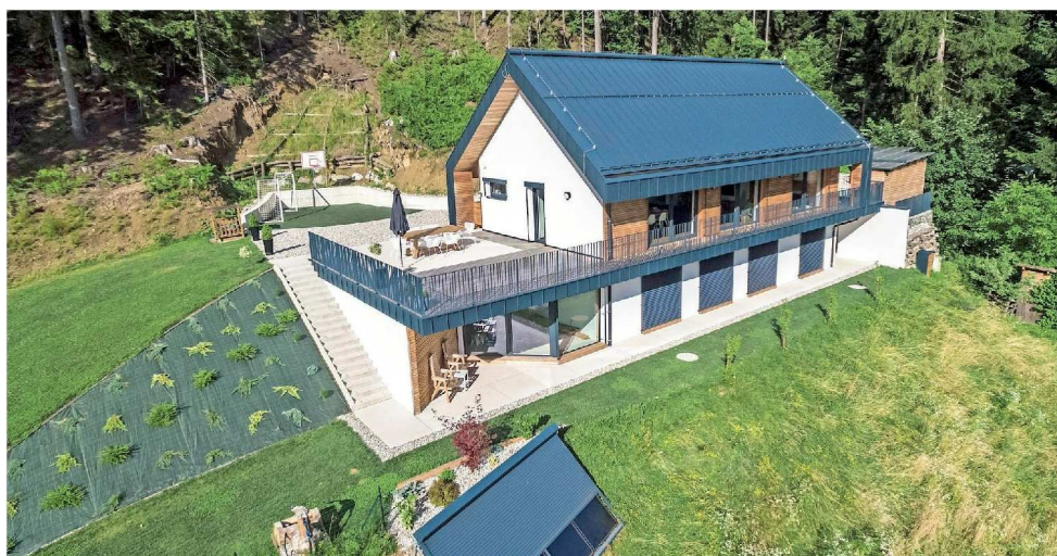
■ Lumar je optimiziral štiri konstrukcijske sisteme zunanjih sten, in sicer Prestige, Pasiv Energy, Pasiv Energy Eco in Masiv.
