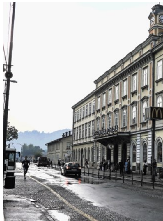
Železniška postaja v Ljubljani, kot kaže, še dolgo ne bo spremenil
