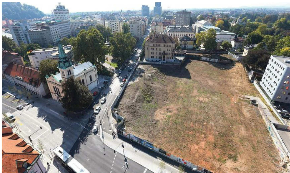
Spor s sosedom na Puharjevi 10 (v desnem zgornjem kotu gradbene parcele ) bi lahko tudi v prihodnje oviral pridobitev gradbenega dovoljenja za zemljišče nekdanjega Kolizeja. FOTO TOMI LOMBAR
