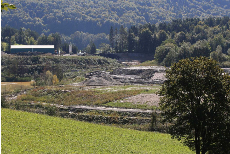
Sanacija peskokopov se izvaja z navozji odpadnega materiala. FOTO: Tomi Lombar
