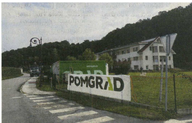
Takoj ko je bilo izdano gradbeno dovoljenje, je izvajalec Pomgrad začel postavljati gradbišče.
