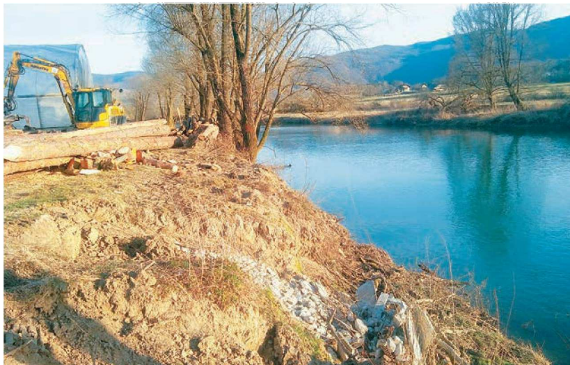
Del gradbenih odpadkov, ki jih je odkrila ekološka patrolja. (Foto: DEZ)
