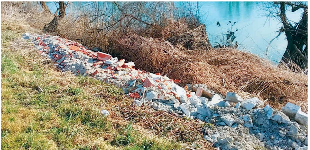
Prejšnji teden so na Malencah začeli urejati brežine in med orstio se je pokazal tudi gradbeni material. (Foto: J. A.)
