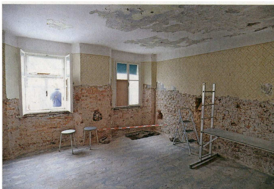
Ukrepi se nanašajo tudi na prenove starejših stanovanjskih stavb. / Foto: Gorazd Kavčič
