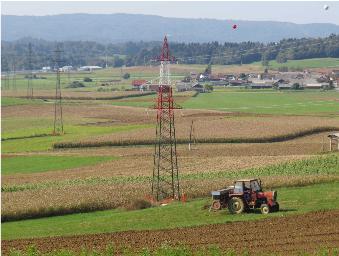
Daljnovod 2 x 110 kV bo izboljšal kakovost elektrike tudi na območju ivanške občine. FOTO: Bojan Rajšek/Delo
