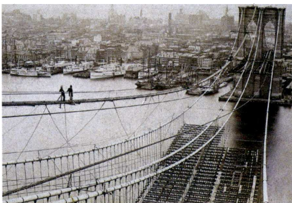
Gradnja Brooklynskega mostu
