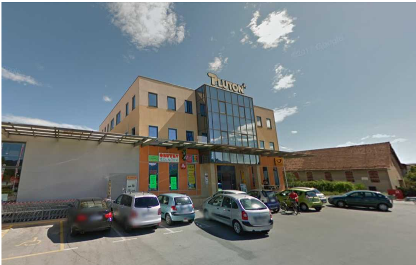
Uporavna stavba nekdanjih Pluton Gradenj. Foto: Google Maps
