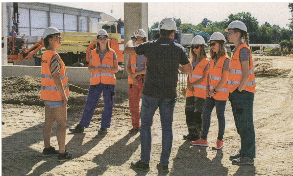
Anna-Maria, Zuzka, Katka, Nevena in Eliška – bodoče gradbinke iz Češke so dva tedna preživele na gradbišču Pomgrada v Puconcih. FOTOGRAFIJA MARINA VRBNJAK
