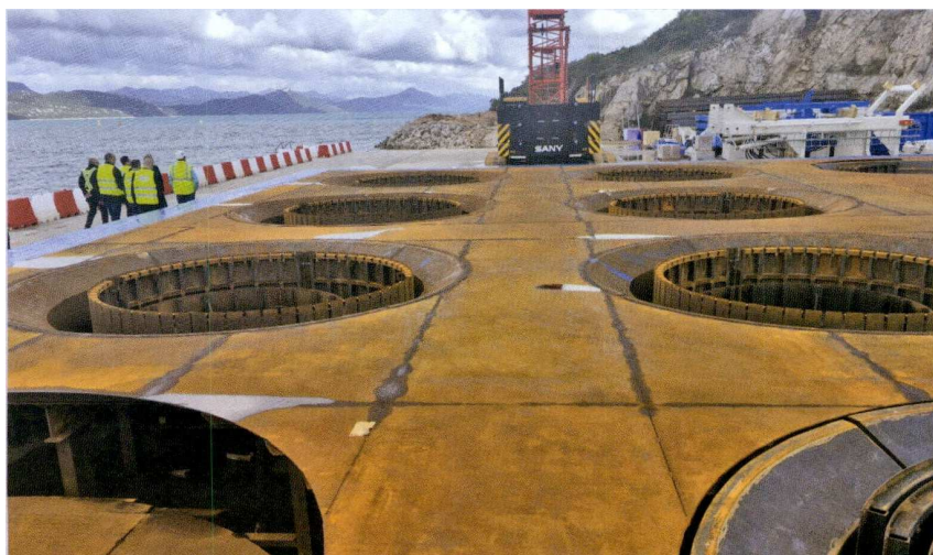
Nadzor nad gradnjo Pelješkega mosta
