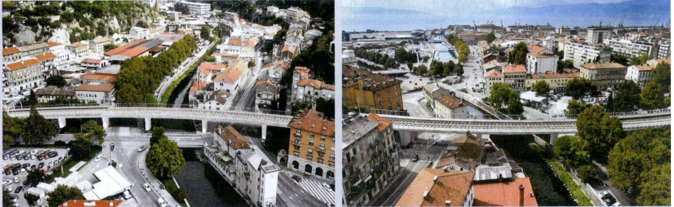
Most Rječina, podvoz Školjič (levo); viadukt Školjič (desno)
