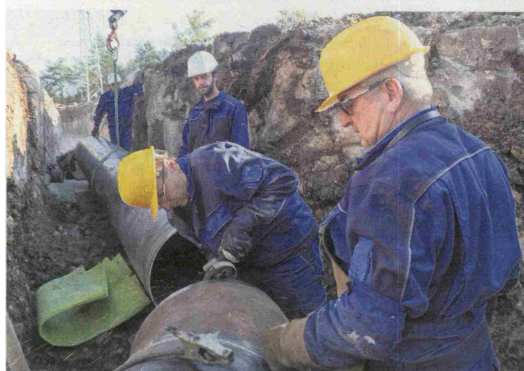
Pri Divači, kjer se bo obstoječa železnica združila z novim drugim tirom, delavci pravkar tudi prestavljajo vodovodne cevi. Na novi lokaciji, nekaj metrov vstran od stare, jih bodo nadomestili z novimi.
