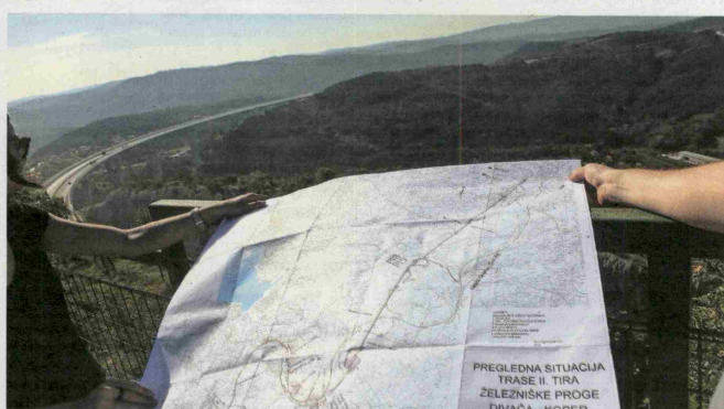
Z viadukta Črni Kal v smeri proti Kopru se odpira pogled na eno največjih trenutno aktivnih gradbišč. Ceste, ki bodo tukaj nastale, bodo vodile do portalov drugega in tretjega predora na trasi nove železnice, nato bo proga prečkala Osapsko dolino z viaduktom Gabrovica, ki bo speljal pod viaduktom Črni Kal.
