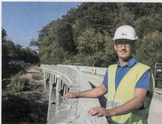
Za dostop do doline Glinščice družba CBE gradi dostopni cesti, po katerih bodo v času gradnje predorov in mostov dovažali in odvažali material. Ker naravovarstveniki ne pustijo uporabe agresivnih sredstev za nasipe, škarpe in oporne stene, tudi betona ne, je pri gradnji potrebne veliko improvizacije. Oporna stena na fotografiji je sicer le začasna in bo umaknjena, ko bo od enega konca do drugega zgrajen 34 metrov dolg most.
