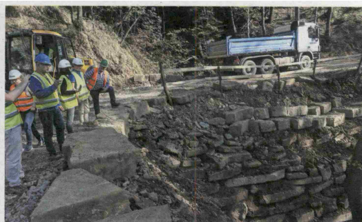
Za dostop do doline Glinščice družba CBE gradi dostopni cesti, po katerih bodo v času gradnje predorov in mostov dovažali in odvažali material. Ker naravovarstveniki ne pustijo uporabe agresivnih sredstev za nasipe, škarpe in oporne stene, tudi betona ne, je pri gradnji potrebne veliko improvizacije. Oporna stena na fotografiji je sicer le začasna in bo umaknjena, ko bo od enega konca do drugega zgrajen 34 metrov dolg most.
