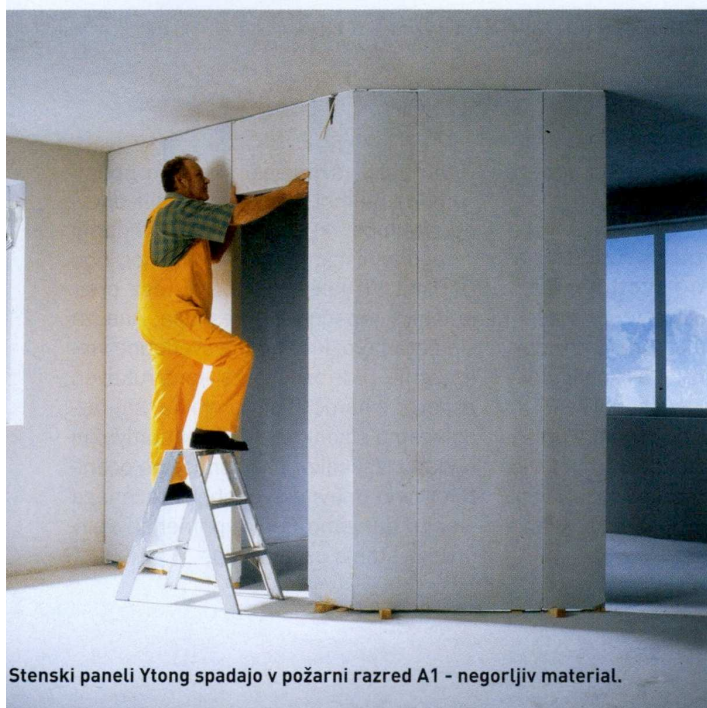
Stenski paneli imajo izjemno gladko površino, kar omogoča preproste popravke in izdelavo sten brez površinske obdelave.
