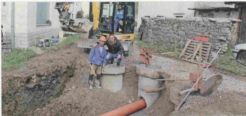
Predsednik vaše skupnosti Selce Simon Ostanek (desno) je pohvalil delavce podjetja Grafist, ki je pri gradnji komunalne infrastrukture skupaj s Kolektor Kolingom podizvajalec Kolektorja CPG.
