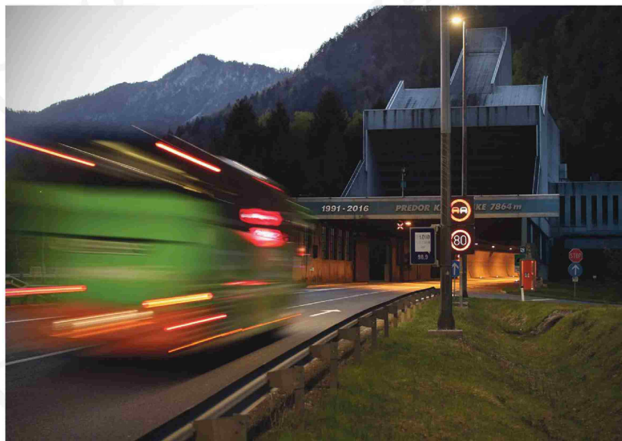
Gradnja vzhodne cevi karavanškega predora bi se lahko začela čez nekaj mesecev, leto in pol za Avstrijo. FOTO JURE ERŽEN
