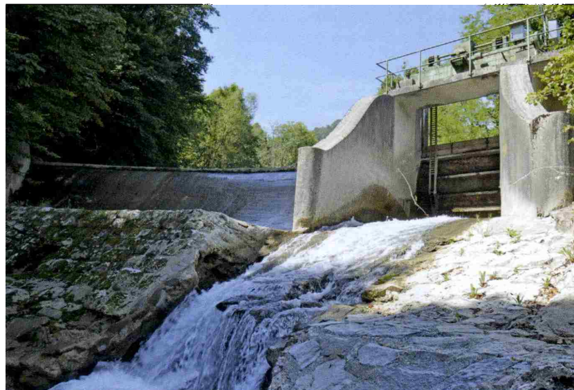
▲ Zajetje hidroelektrarne Škofja Loka na Selški Sori
