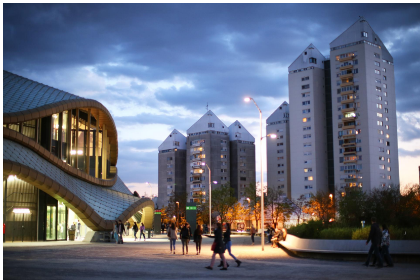
Pogled na prenovljene stanovanjske objekte ob Areni Stožice. Foto Jure Eržen
