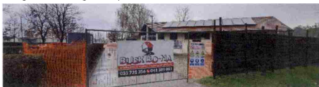
Prenova sanitarnega objekta v Termah Ptuj
