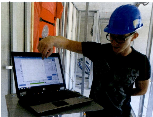
Slika 2: Pri gradnja sodobnih stavb, sNES, je pomemben vidik ciljno doseganje zelene zrakotesnosti ovoja stavbe – izvedba testa zrakotesnosti. Foto: GI ZRMK
