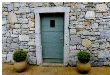
Sliki 13 in 14: Omet ima poleg okrasne tudi zaščitno vlogo. Zidake, kamnite in opečne, ter vezivo ščiti pred zunanjimi vplivi. Trenutno modno odstranjevanje ometov ni ravno prava pot popravilja in posodabljanja starih arhitektur, posebej ne, če je gradivo izpostavljeno zunanjim vplivom.
