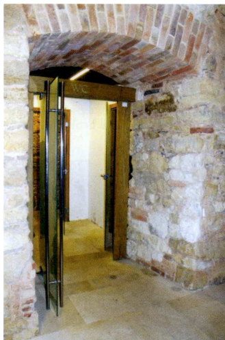
Sliki 13 in 14: Omet ima poleg okrasne tudi zaščitno vlogo. Zidake, kamnite in opečne, ter vezivo ščiti pred zunanjimi vplivi. Trenutno modno odstranjevanje ometov ni ravno prava pot popravilja in posodabljanja starih arhitektur, posebej ne, če je gradivo izpostavljeno zunanjim vplivom.
