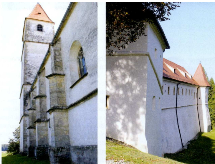
Sliki 11 in 12: Uporaba ometa se je začela uveljavljati v 16. stoletju. Omet, namenjeni izključno zaščiti, so bili sprva tanki (tankoslojni), tako da je skozi prosevala kamnita konstrukcija, ki je kazala kakovostno gradnjo iz obdelanih kamnitih elementov (klesancev) (slika 11). Z večanjem gradnje v kamnu je zahtevno tehniko priprave kamnitih elementov zamenjala manj zahtevna, uporabljali so neobdelan ali le delno obdelan kamen, debelina ometov se je povečala in zaščitni vlogi je bila dodana krasilna (slika 12). Foto: Živa Deu, Matjaž Deu
