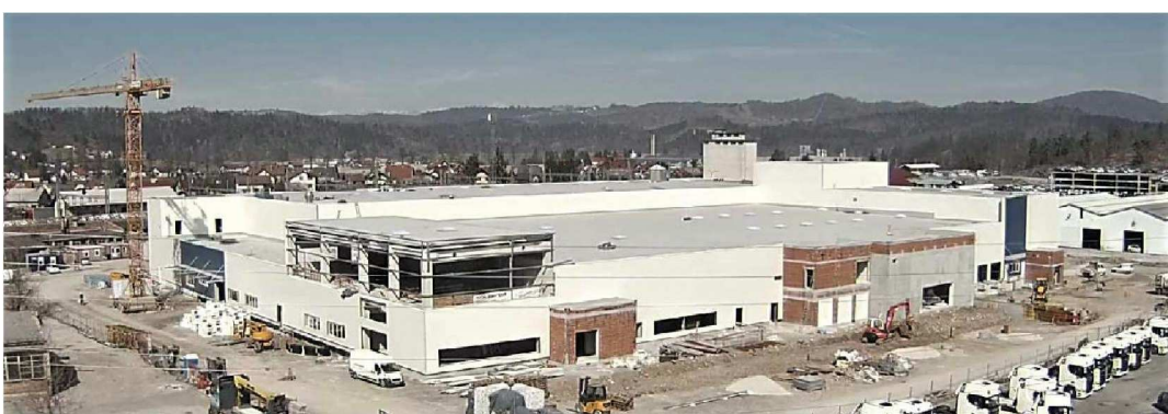
■ Pogled na Lonstrott z gradbiščne kamere
