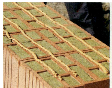
Lepljenje zidakov. Izolacija je vtisnjena v prekate.
