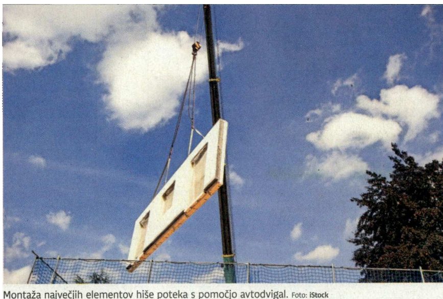
Montaža največjih elementov hiše poteka s pomočjo avtodvigal. Foto: iStock
