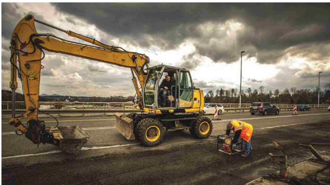
Gradbena podjetja že opažajo zastoje pri delih na državnih cestah. Upad javnih naročil je občuten, pravi vir iz gradbenštva. FOTO VORANC VOGEL
