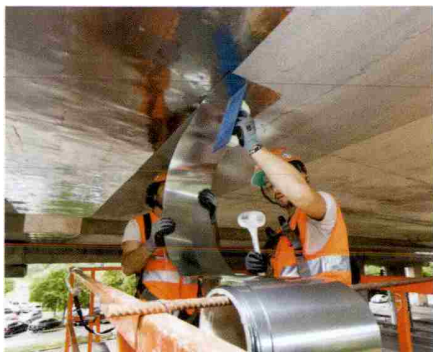
Mapeshield E25 samolepilne plošče iz cinka se namestijo na beton.
