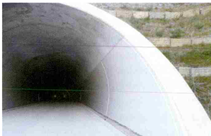
Zaščita betonskih sten predora Markovec z namensko dvokomponentno epoksidno barvo s »keramičnim« izgledom MAPECOAT I 650 WT. Ta nudi potrebno zaščito pred prodiranjem škodljivih snovi in boljšo refleksivnost površine, s tem pa tudi boljšo vidljivost in večjo varnost.
