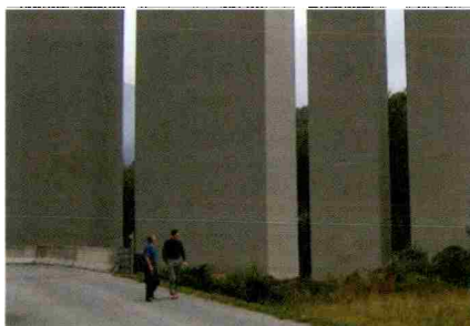
Dekoratívna zaščita zagladitvenega sloja Mapelastica z visoko elastično barvo Elastocolor Pittura
