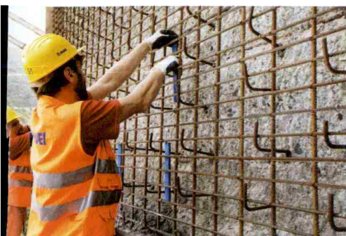
Nameščanje anod Mapeshield I 30/20 za katodno galvansko zaščito
