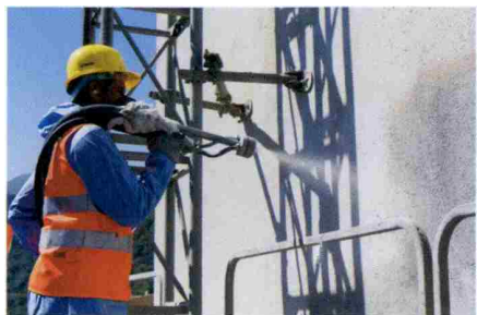
Nanos malte Mapelastick Guard z brizganjem za zaključno zaščitno obdelavo
