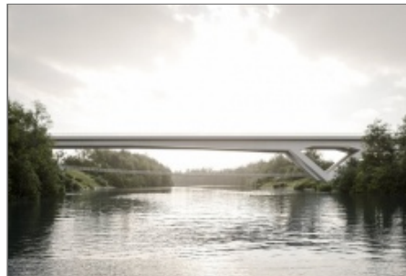
Most v Ločni so med projektiranjem podaljšali za približno 200 m, s čimer so dejansko za toliko skrajšali nasip, ki bi ga morali zgraditi. (Vir: Ponting, d. o. o., in Pipenbaher inženirji, d. o. o.)
