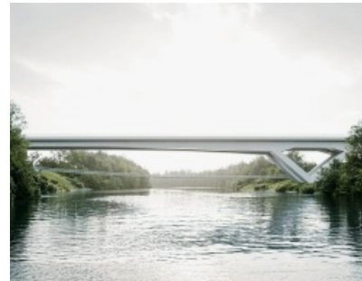
Most v Ločni so med projektiranjem podaljšali za približno 200 m, s čimer so dejansko za toliko skrajšali nasip, ki bi ga morali zgraditi. (Vir: Ponting, d. o. o., in Pipenbaher inženirji, d. o. o.)
