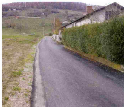
Voda, ki priteče po cesti, zdaj naj ne bi več poplavljalja hiš.
