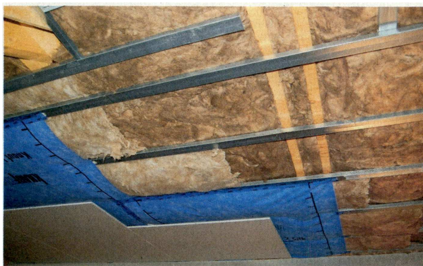
Steklena volna je toplotna in zvočna izolacija, ki jo sestavljajo prepletena steklena vlakna, med katerimi je ujet mirujoč zrak.
