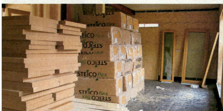
Lesna vlakna se po posebnem postopku stiska v lesnovlakenne plošče različnih gostot za različne namene uporabe. Foto: dokumentacija Dnevnika
