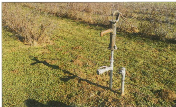
Izvedena vrtina za namakanje nasada aronije
