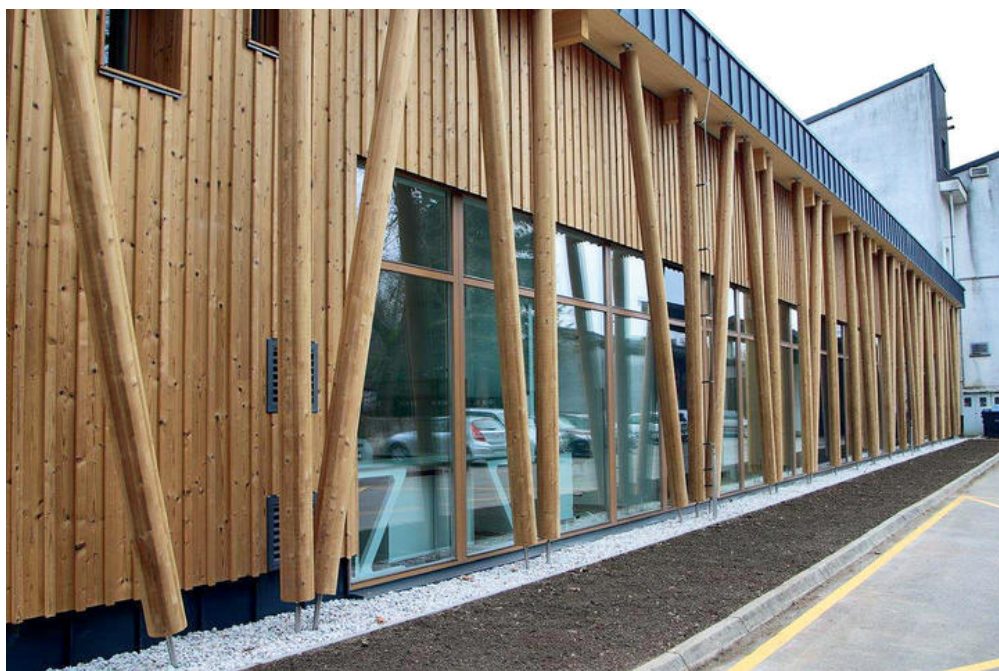
Slika 3: Fasada in stavbno pohištvo iz termično modificirane smrekovine (foto: arhiv Silvaprodukt).
