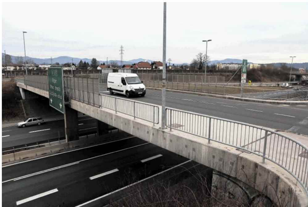
Pri odločitvi o začetku rekonstrukcije priključka Letališke ceste na obvoznico bosta Dars in ljubljanska občina upoštevala več dejavnikov. (Foto: Luka Cjuha)
