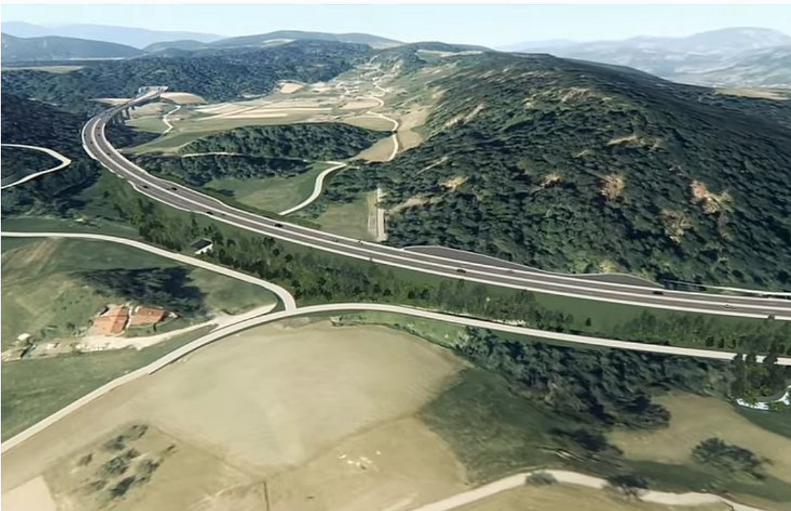
Se bo gradnja lahko začela že letos? Foto: PNZ
